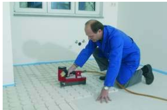
ThermoFloor Module mit Lastverteilschicht verbinden
