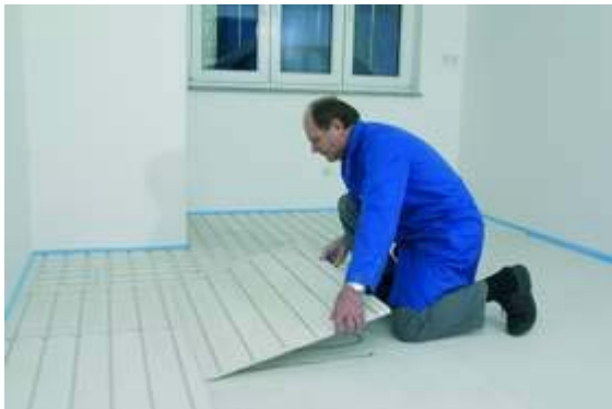
ThermoFloor Module verlegen
