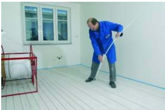
Multiflex-Verbundrohr einlegen
